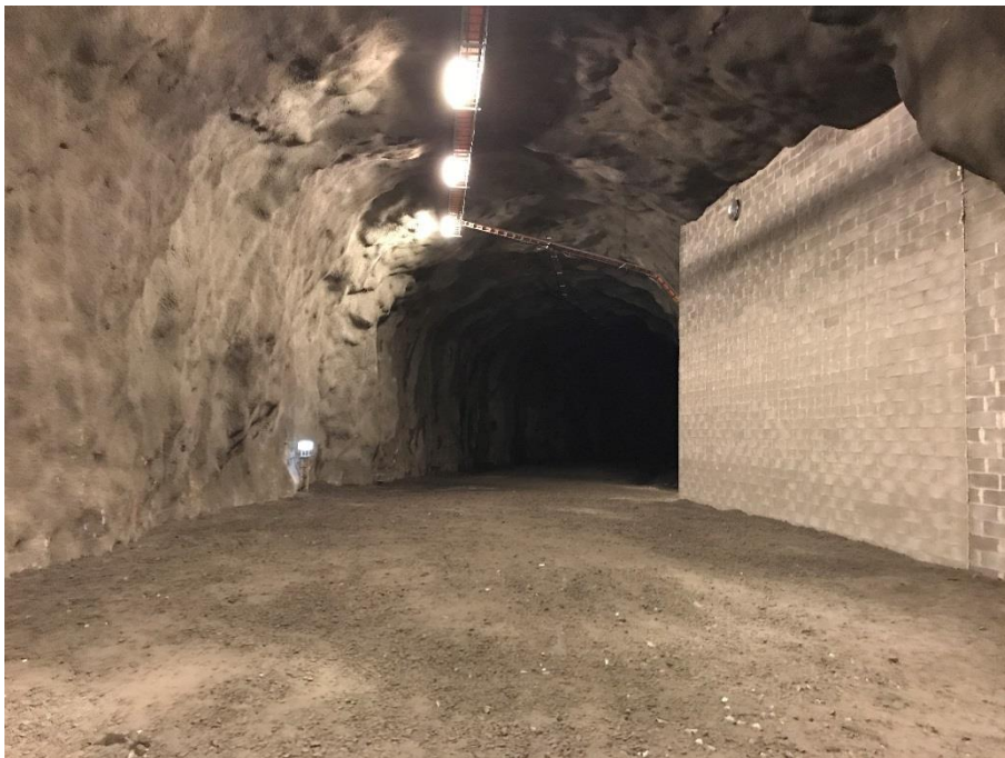
Kuva 5.2, Olemassa oleva ilmanvaihtotunneli, oikealla tekninen tila NK3
