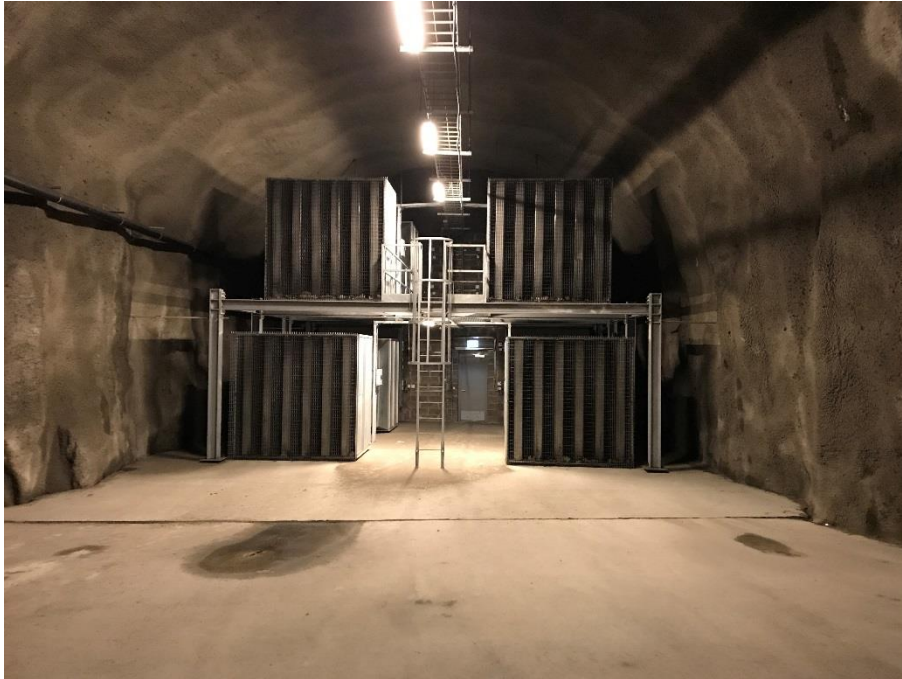
Kuva 5.16, Rantaväylän päätunnelit ylittävällä yhdysväylällä ja sillalla S4 sijaitsevat ilmanvaihtolaitteet on siirrettävä uuteen paikkaan
